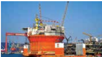
2015 02 세계 최대 원통형 굴리앗 FPSO 출항
